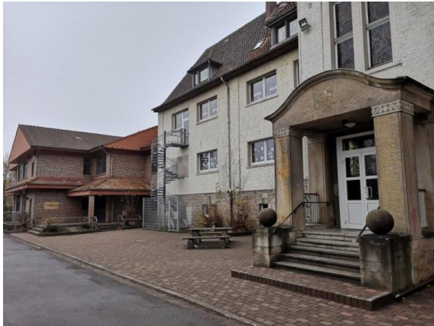
Zuerst wird der Altbau trakt der Grundschule Neesen saniert, danach der Neubau. Foto: MT-Archiv (© Korfemeyer Carsten)
